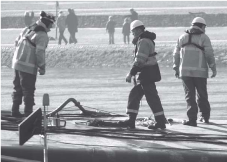
Der Schiffsrumpf wurde angebohrt, um Proben zu entnehmen. Nachdem der Wasserstoff mit Stickstoff verdrängt werden konnte, bestand keine Explosionsgefahr mehr.
