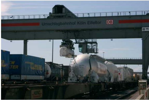
Der größte Containerbahnhof Deutschlands, Köln-Eifelort, verfügt über sechs Containerbrücken. Die Zuweisung zu den bestimmten Lagerplätzen bzw. auf die jeweiligen Tragwagen erfolgt elektronisch.
