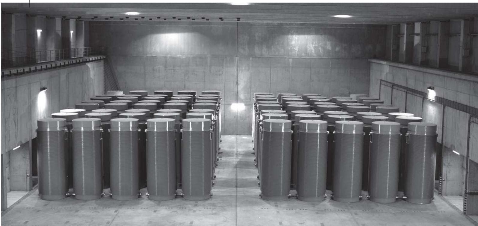
*Im Zwischenlager werden die Behälter 40 Jahre gelagert. Der radioaktive Inhalt klingt in dieser Zeit ab. Danach erfolgt die Endlagerung.*
